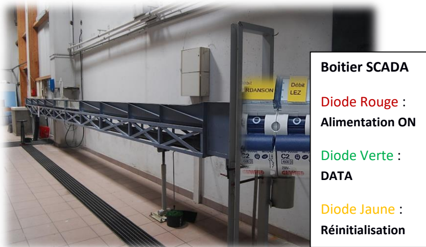
Figure 4 : Petit canal Verdanson
