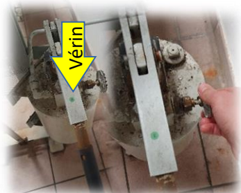
Figure 5 : Robinet du vérin hydraulique
